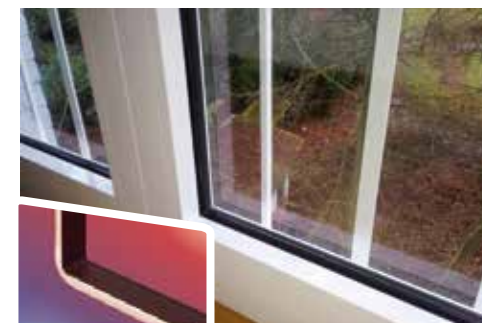
Matzwarte ECOTEK spacer valt niet op in tegenstelling tot de aluminium afstandhouder
